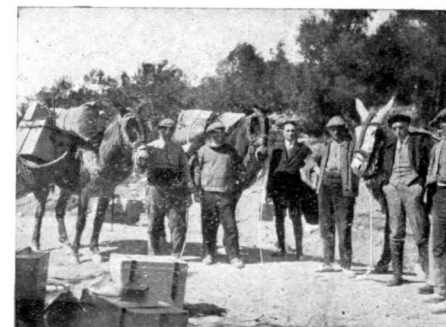
FIG. 46.—Transporte de un equipo sísmico Fot. Siñeriz
